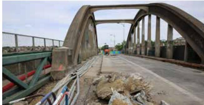
La première phase du chantier est consacrée au « dévoiement » des réseaux avant la démolition de la chaussée et des trottoirs, la suppression et la reprise de l'étanchéité et la reconstitution de la chaussée. Un chantier important qui se déroulera durant l'été car nécessitant la fermeture complète de la circulation. Seuls les piétons peuvent continuer à emprunter le pont par des cheminements sécurisés.
